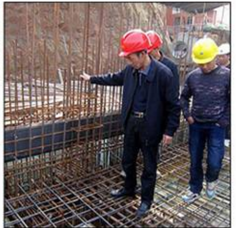
人防工程建设
