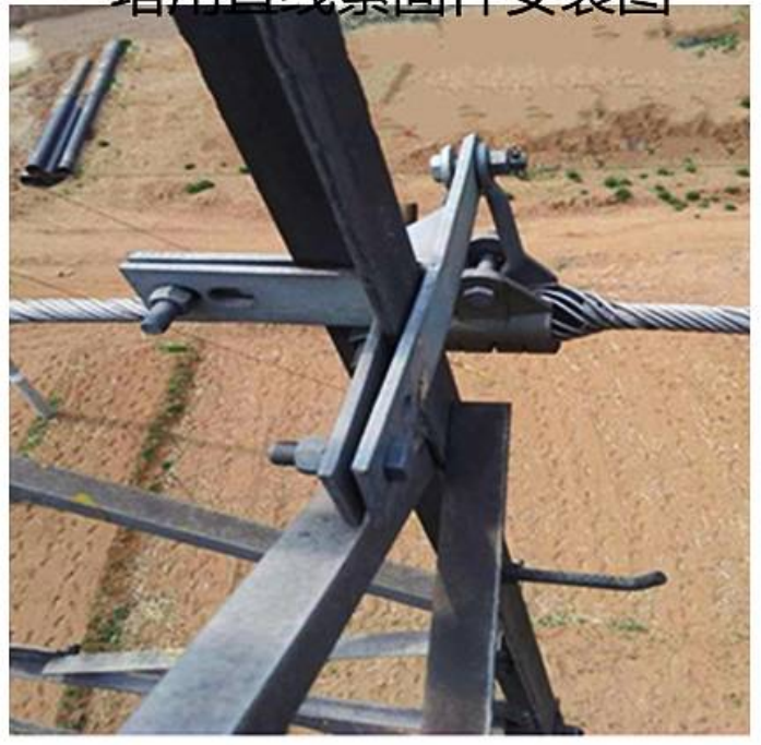
塔用直线紧固件安装图
