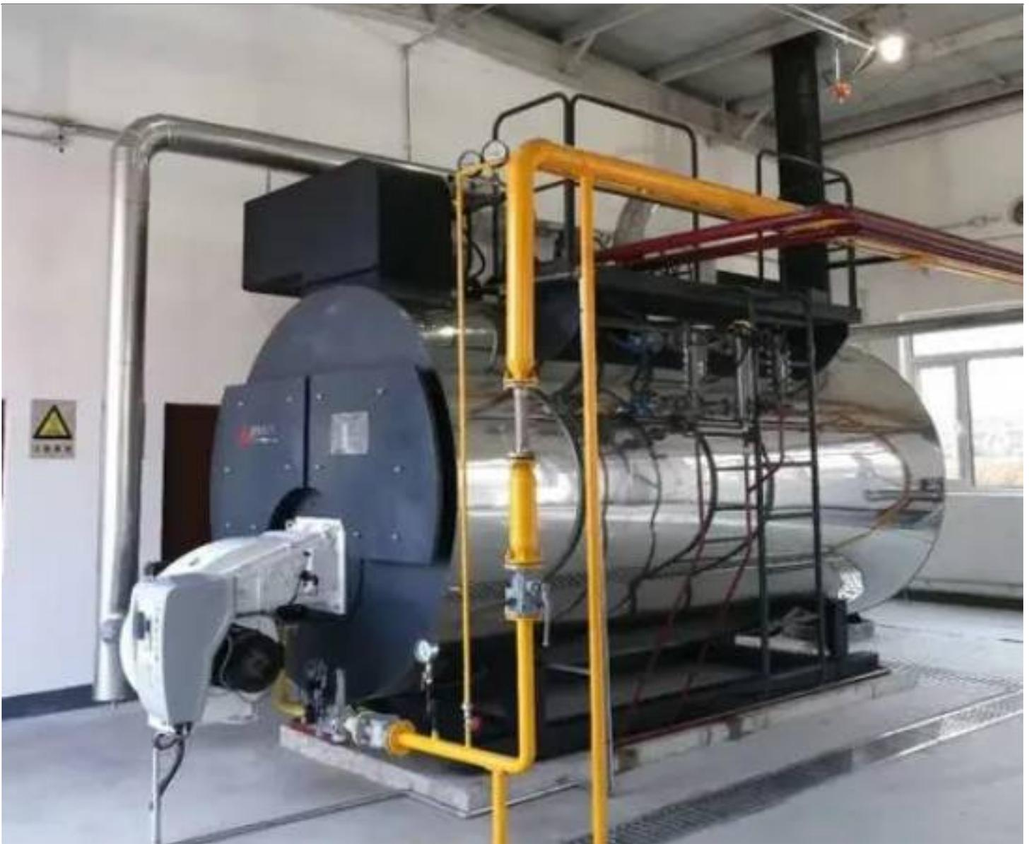
燃气式导热油炉是利用燃气作燃料，通过燃烧产生的高温气体将导热油加热，再通过导热油传递热量。这种炉子具有自动化程度高、热效率高、温度控制准确等特点。它常用于油田、化工、制药等行业，在石油钻机、化工反应釜、蒸发器等设备中有广泛应用。
