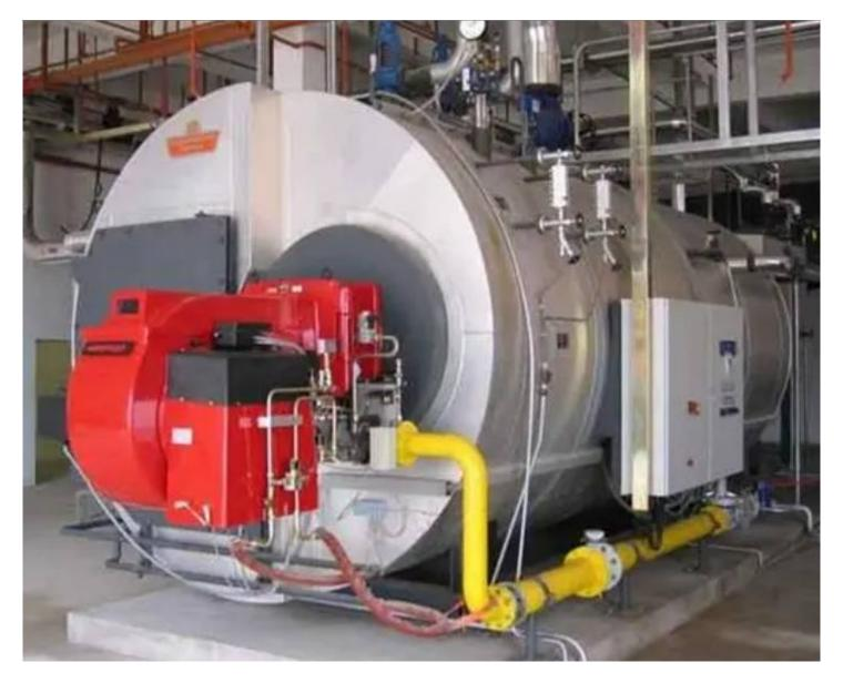
燃气蒸汽锅炉通过燃烧燃气产生蒸汽,将蒸汽输送到各个供暖或热水设备中。蒸汽以高温高压状态运行,有效地传递热能。而燃气锅炉冷凝燃气锅炉则通过燃烧燃气产生热水,在供暖和热水过程中,通过回收燃烧产生的烟气中的热量,将其冷凝成水再利用,提高能源利用效率。
