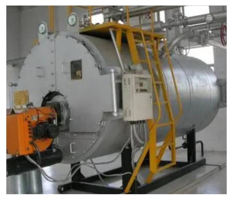
卧式燃油气热水锅炉是一种广泛应用于家庭采暖的锅炉。其特点是结构紧凑、占地面积小,适用于安装在狭小空间的需求。此外,该类型锅炉采用先进的螺旋烟管技术,具有高效能、持久耐用的特点。它能够自动调节温度,保持室内舒适的温暖。
