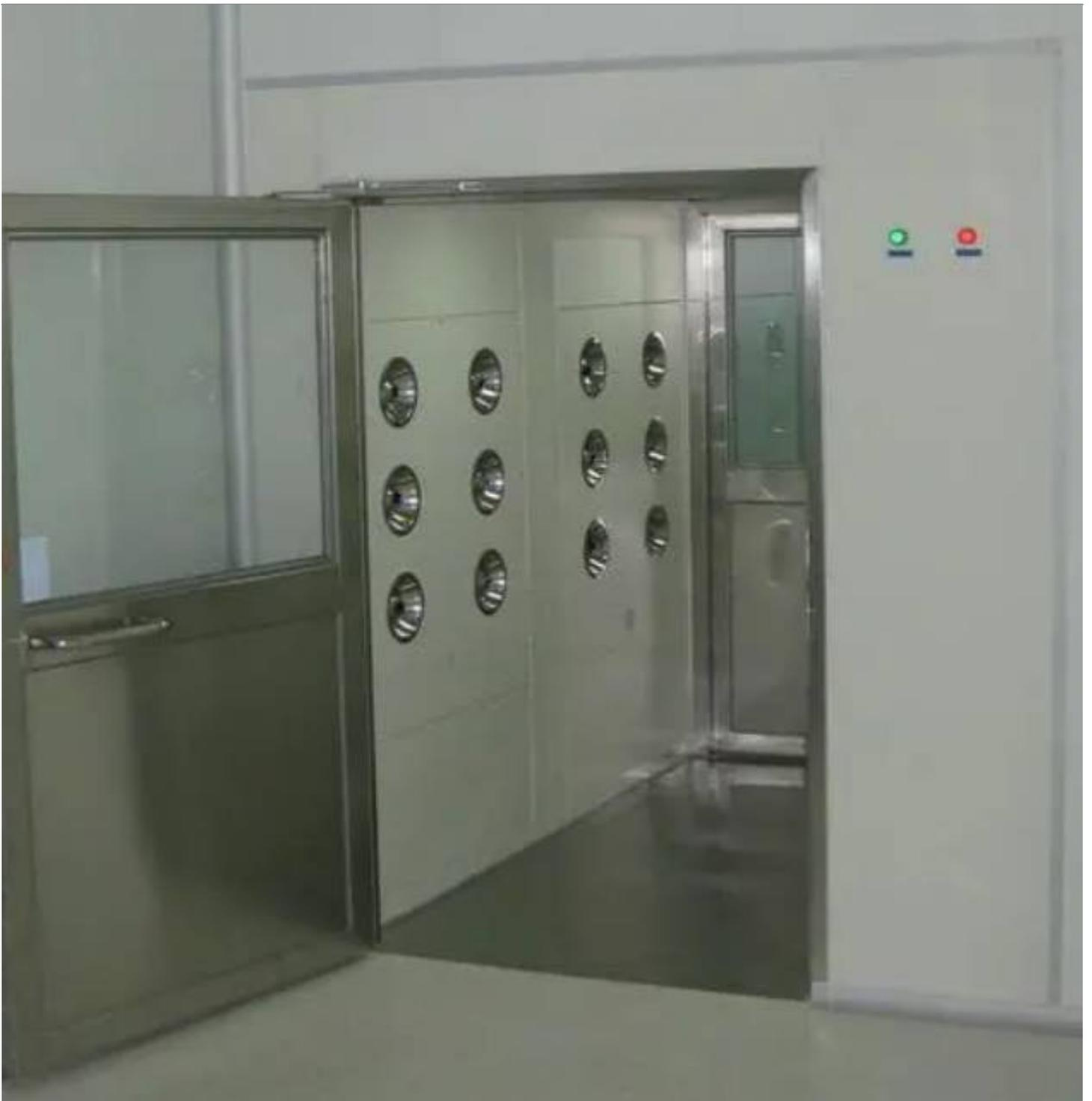
通道式风淋设备的另一个重要特点是其高效的空气过滤系统。通常采用高效过滤器和HEPA过滤器，有效过滤微粒、细菌和病毒等有害物质，确保洁净环境的标准。这种过滤系统还能阻隔异味和有害气体的扩散，保证使用者的健康和安全。
