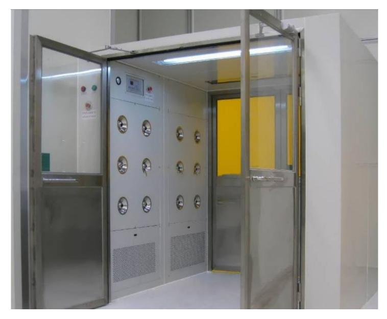
智能电子车间风淋室在车间空气净化中发挥着关键作用。由于电子车间的特殊工作性质,尘埃和微粒会在生产过程中产生,并可能对产品的质量和可靠性造成影响。而智能电子车间风淋室的过滤系统可以有效去除这些有害物质,提高车间空气质量,保障产品品质的稳定性。
