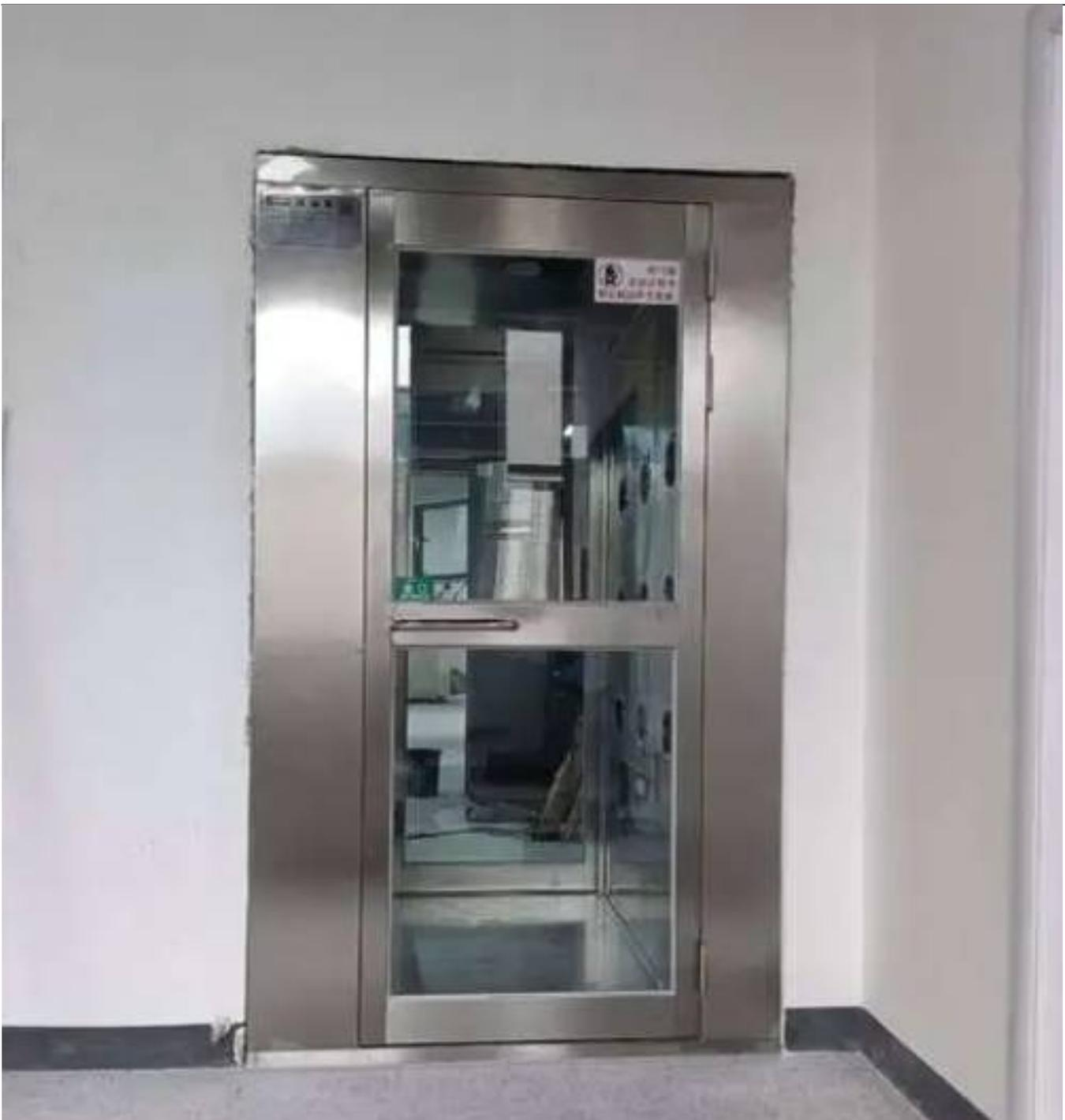
厂房净化风淋门作为通道型风淋室的重要组成部分，起到了阻隔灰尘、细菌等污染物进入厂房的关键作用。它采用了先进的净化技术，通过强大的风力将外界的空气进行过滤和净化，确保进入厂房的空气质量达到符合要求的标准。同时，厂房净化风淋门还具备智能感应、快速开合、密封性好等特点，使其成为现代化厂房净化的不可或缺的存在。
