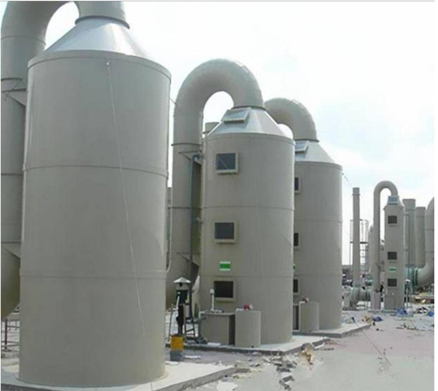
尾气净化过程中，聚四氟乙烯填料塔发挥着至关重要的作用。首先，尾气通过管道进入填料塔，经过填料层的分布，使尾气与填料充分接触，从而将污染物吸附在填料表面。填料塔内部的循环液体通过循环泵的作用，将吸附的污染物带出填料层，形成废液。待废液达到一定浓度后，进入酸碱中和塔进行中和处理。最后，经过处理后的尾气经过抽风机排出，实现了尾气的净化和排放。
