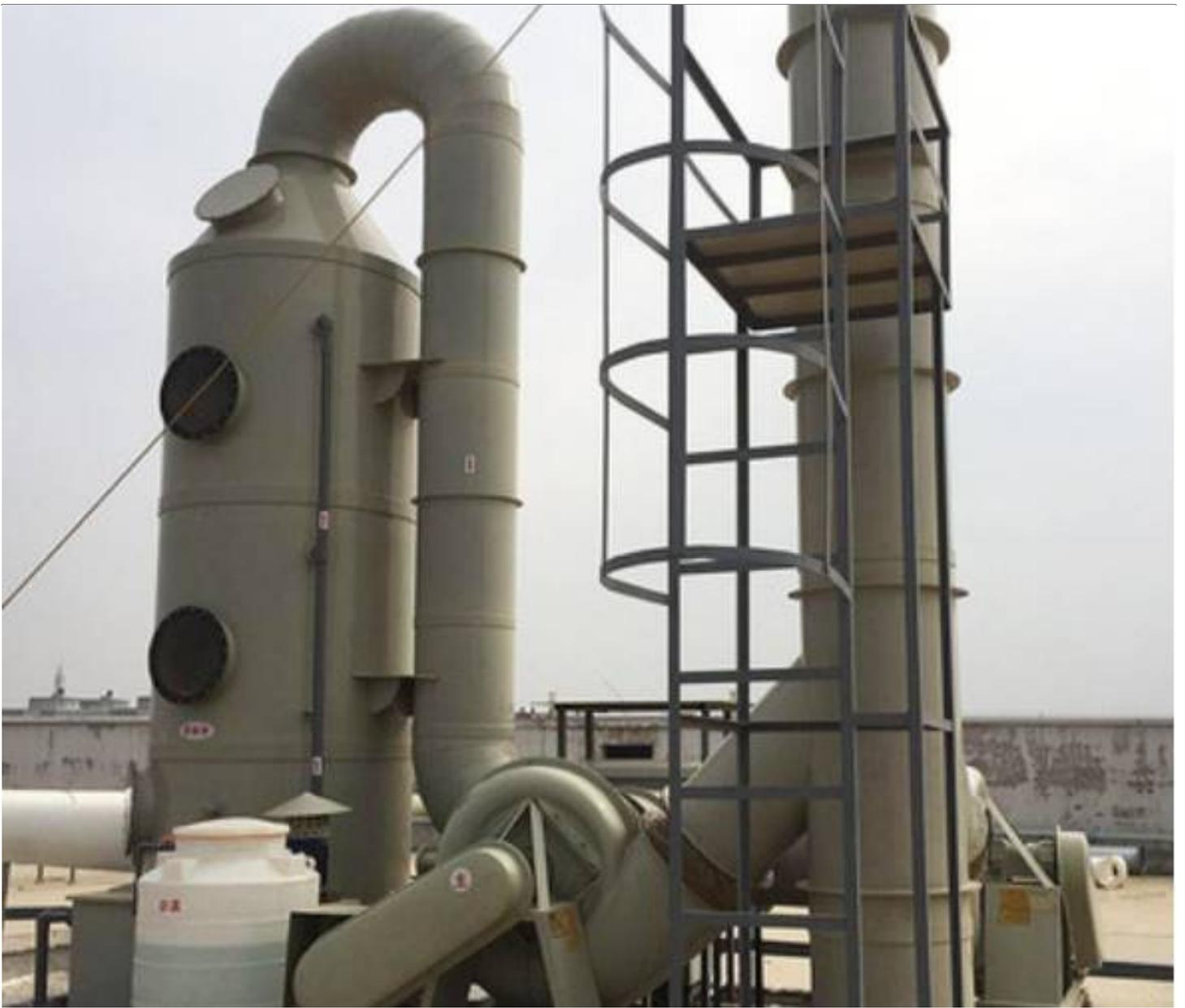
氯化氢吸收器是一种专门用于吸收氯化氢气体的设备。氯化氢是一种具有刺激性和腐蚀性的气体，常用于工业生产中的化学反应和矿山冶金过程中。氯化氢吸收器通过特殊的吸收剂和吸收塔的设计，将氯化氢气体与吸收剂充分接触，从而实现气体的吸收和处理。氯化氢吸收器广泛应用于化工、矿山等行业，能够有效地降低气体排放的污染和对环境的危害。
