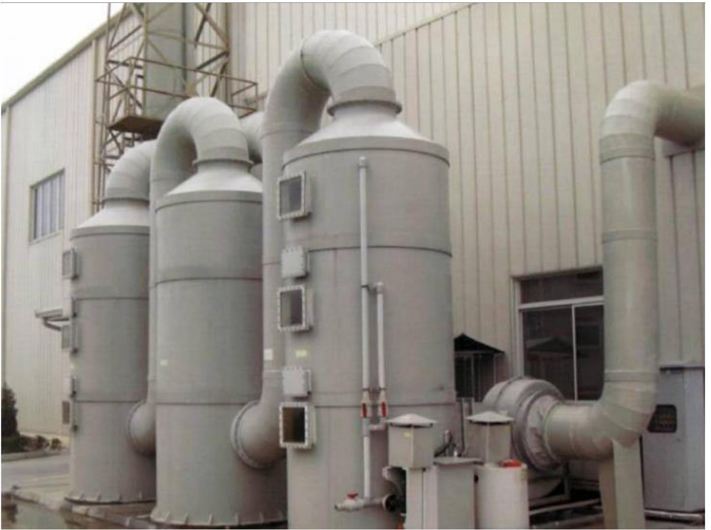
要了解聚丙烯PP填料塔的特性和应用，就不得不提到它的耐腐蚀耐高温性能。聚丙烯PP材质具有优异的耐酸碱腐蚀性能，可以在强酸强碱的环境中稳定运行。并且，该塔还具有良好的耐高温性能，能够在高温下保持稳定的工作状态。这种特性使得聚丙烯PP填料塔在化学工业中得到广泛应用，特别是在酸碱生产、离子交换等环节中发挥着重要的作用。
