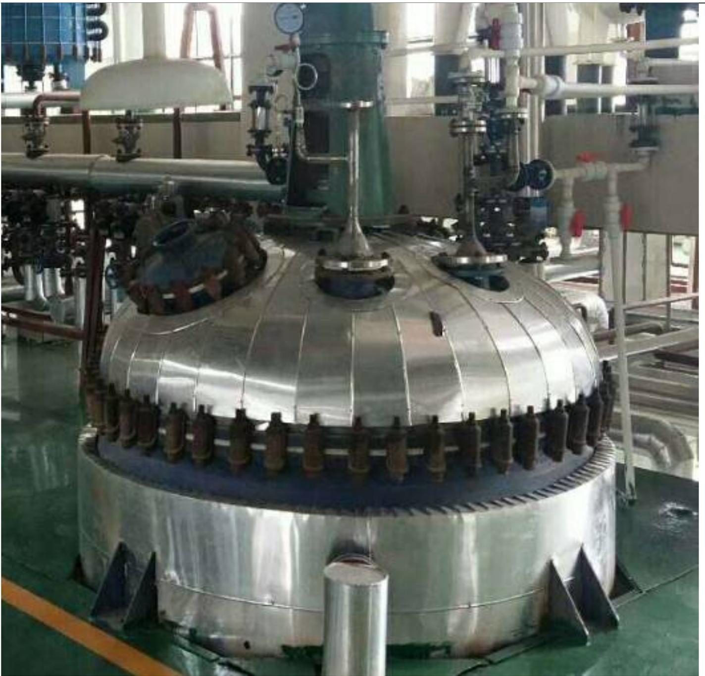
其次，搪玻璃反应釜是一种采用搪玻璃材料制成的反应设备。搪玻璃材料具有耐酸碱、耐热、导热性能好等特点，因此搪玻璃反应釜在化学合成中得到了广泛的应用。它可以承受较高的温度和压力，并且对各种化学试剂具有良好的兼容性。搪玻璃反应釜常用于药物合成、有机合成、催化反应等实验中，其安全可靠的特性深受研究人员的青睐。
