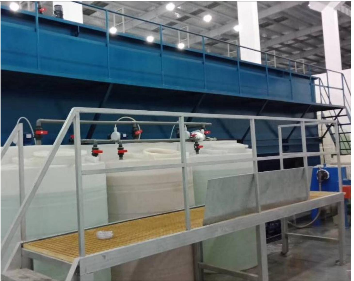
首先，反应池是化工厂污水处理生化处理设备中不可或缺的一部分。反应池根据不同的处理需要，可以分为厌氧池和好氧池。厌氧池主要用于有机物的降解和产气，而好氧池则用于有机物的氧化和去除。在反应池中，通过合理控制温度、氧气供应和搅拌等参数，可以有效提高污水处理效果。
